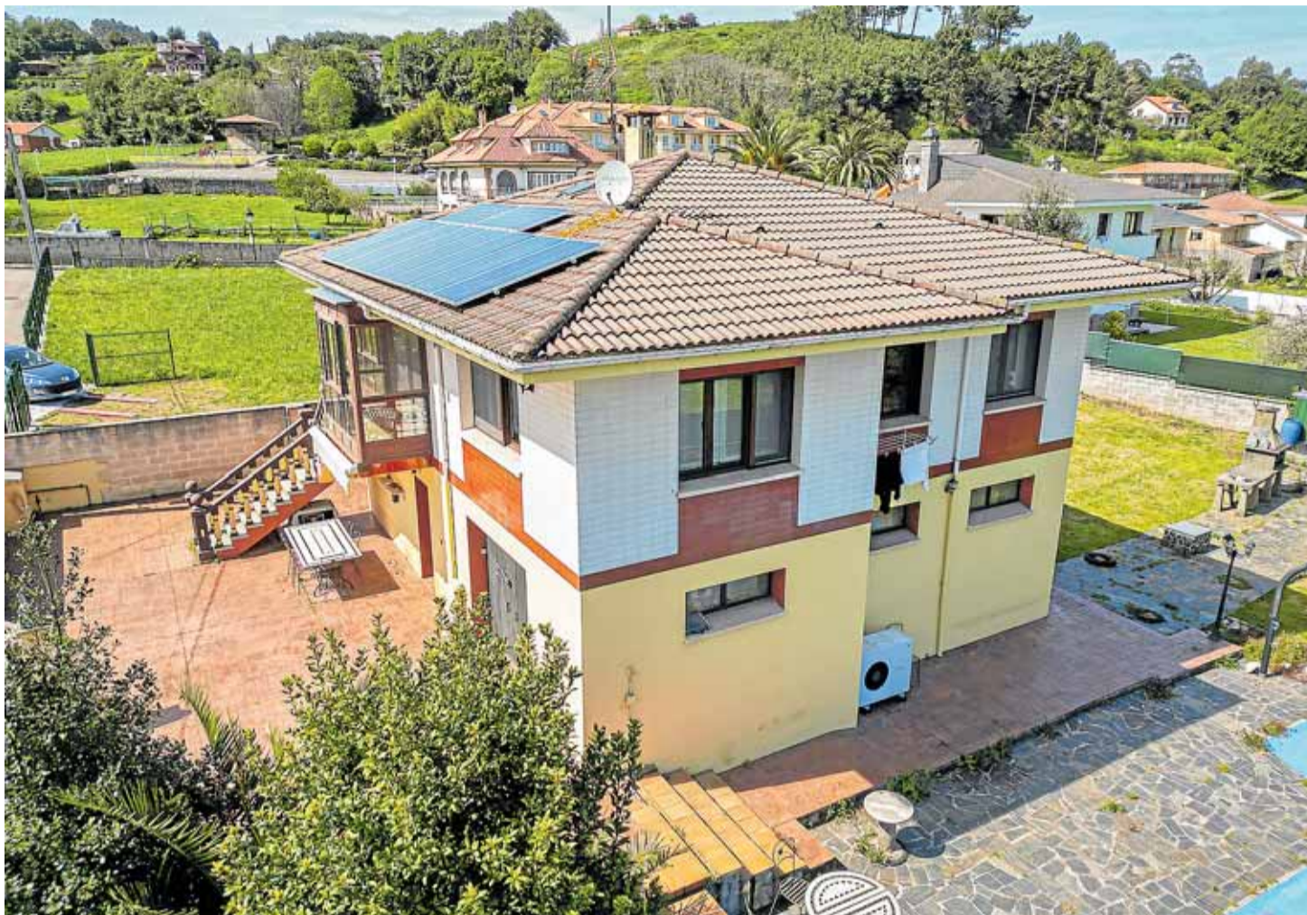
Una vivienda en la que se ha combinado aerotermia con energía solar.
