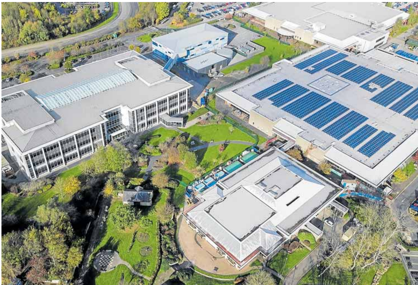
Uno de los hospitales de Grecia en los que se han instalado paneles fotovoltaicos.
